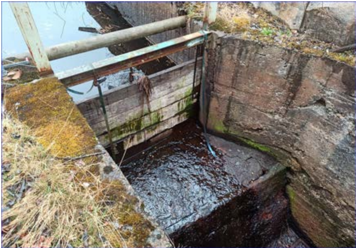
Figur 62: Vandringshinder nummer 2 utgörs av en reglerbar dammlucka i en sidofåra.
