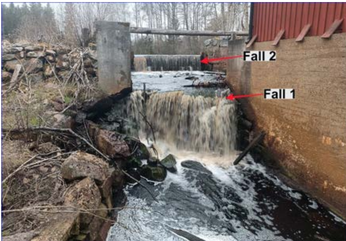
Figur 65: Bilden visar vandringshinder nummer 5 som utgörs av fall i två steg, vilket utgör ett definitivt hinder för både stark- och svagsimmande fiskarter.
