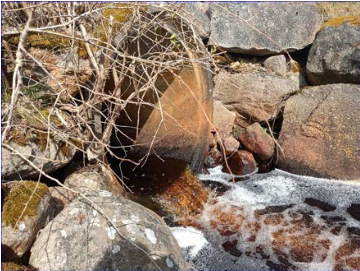
Figur 69: Vandringshinder nummer 7 består av en vägtrumma med ett mindre fall.
