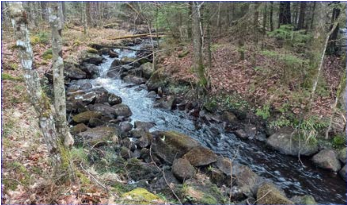
Figur 6: En vanlig syn i Kilingaån. En kraftigt rensad strömsträcka där vattendraget rinner genom storblockig moränmark (sträcka 33). Block och grövre strukturer har rensats ut och ligger längs fårans kanter. Bristen på heterogenitet i bottensubstratet tillsammans med den ökade flödeseffekten innebär en bland annat en kraftig minskning av funktionella strömhabitat för fisk och andra limniska organismer.
