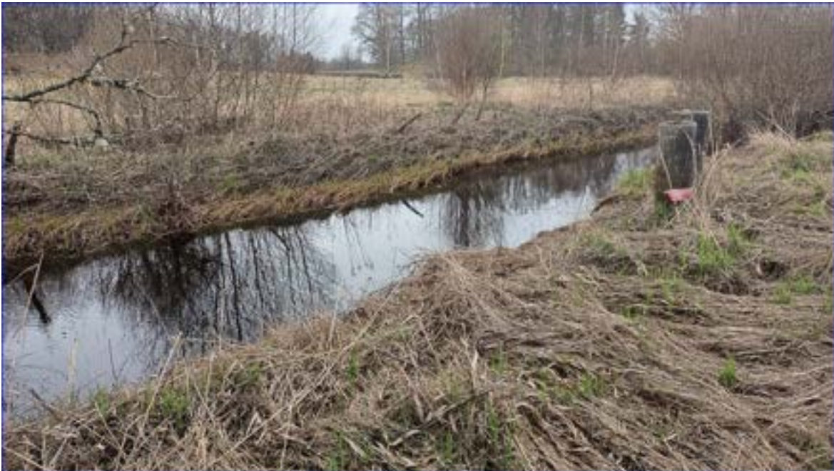
Figur 9: Omgrävda och rätade sträckor genom torv uppvisar över lag mycket dåliga översvämningsfrekvenser och bristfälliga kantzoner. Omgivande våtmarker har blivit onaturligt torra och torven har i många fall oxiderat och sjunkit ihop, vilket leder till näringsläckage, brunifiering och en försämrad vattenhushållning. Bilden visar sträcka 13.
