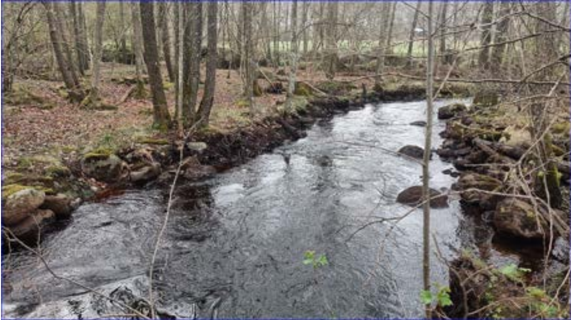
Figur 46: Kraftigt rensad strömsträcka (sträcka 3) med brist på strukturer och en homogen botten, ökad specifik flödeseffekt, avsmalnad och överdjupad fåra. Lekgrus har troligtvis spolats nedströms och uppväxthabitat för öring är förlorade.
