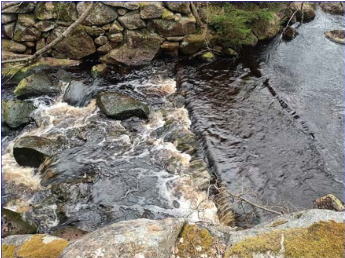
Figur 68: Vandringshinder nummer 6 består av en tröskel efter en utriven damm som skapar ett fall. Upptröskling bedöms vara det enklaste alternativet för att förbättra den longitudinella konnektiviteten.
