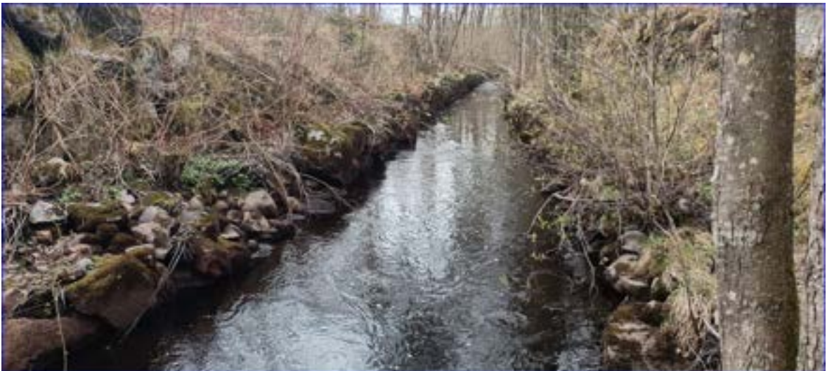
Figur 47: Omgrävd strömsträcka (sträcka 12). De grävsta blocken är utrensade och ligger längs fårans kanter. Den ökade specifika flödeseffekten som bristen på grövre och energiförbrukande strukturen och den kanaliserade fåran leder till innebär att vatten passerar snabbare genom systemet, både vid låg och högflöden.
