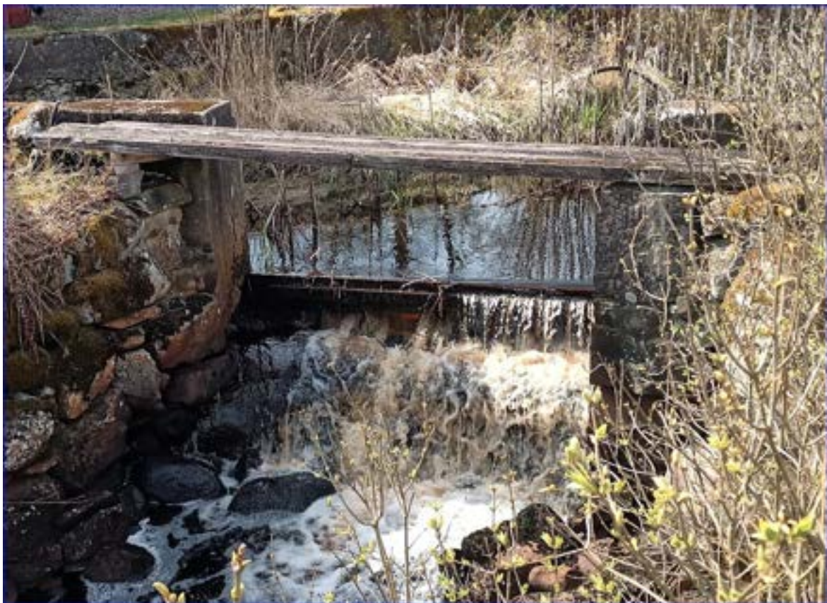
Figur 70: Vandringshinder nummer 8 består av en tröskel för sjöyta samt ett fall som skapats av rensningen av fåran.
