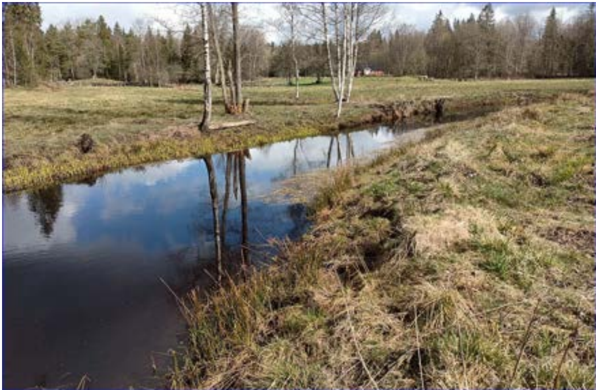
Figur 26: Omgrävd och rätad sträcka genom ursprunglig torvmark där påverkan har syftat till att avvattna marken för jordbruk. Idag utgörs omgivande marker enbart av betesmarker vilka kan tåla en högre översvämningsfrekvens (sträcka 60.) Genom att återställa nedströms utrensade strömnacke hade grundvattennivån kunnat höjas och kontakten med omgivande madmarker hade förbättrats.
