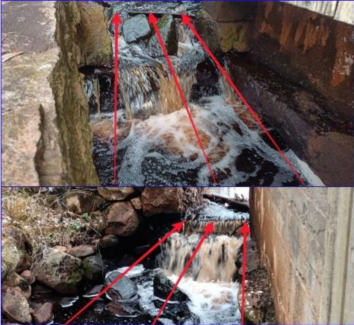
Figur 73: Upptröskling hade inneburit att man successivt trösklat upp med lämpligt material upp till nuvarande fallnivå för att slå ut fallhöjden.
