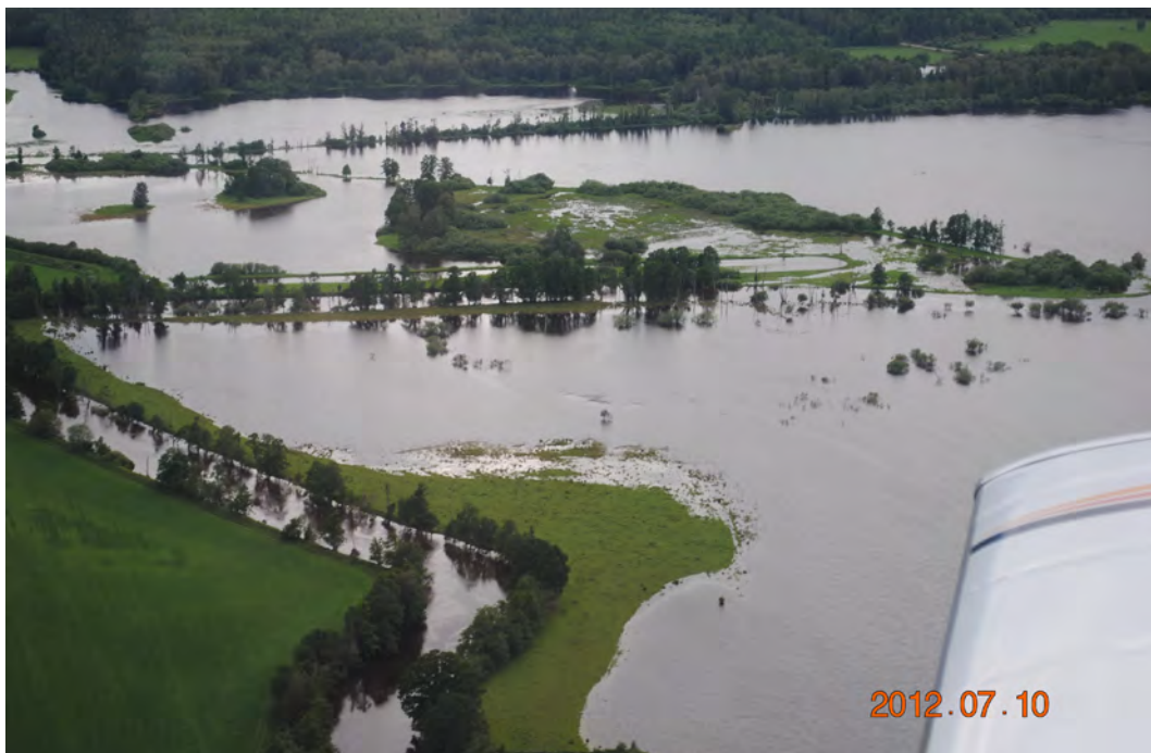
Sommaren 2012 översvämmades Emån efter ett häftigt regn med lokala nederbörds mängder över 100 mm. Översvämningarna påverkade både verksamhetsutövare och naturvärden efter ån. Ett uppföljande och förebyggande arbete pågår mellan länsstyrelserna, kommunerna, näringslivet och intresseorganisationer för att dämpa konsekvenserna av kommande skyfall. Foto Kustbevakningen.
